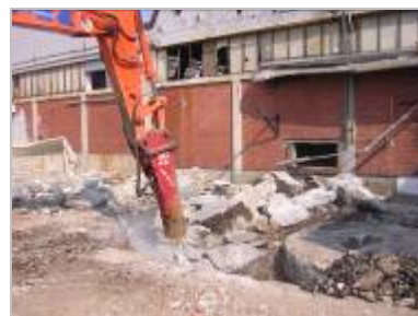
Bonifica e demolizione di serbatoi dismessi e di terreno contaminato da idrocarburi.
