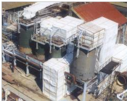
Bonifica di impianti in un sito petrolchimico.
