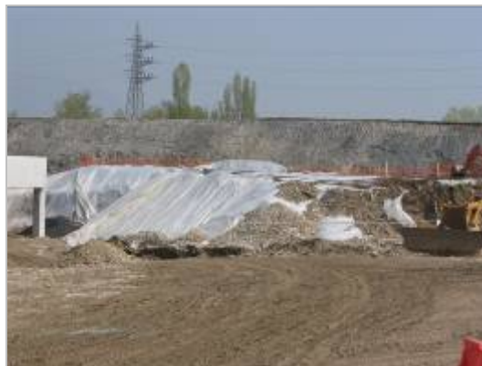
Bonifica ex discarica di scorie di fonderia contaminate ulteriormente da frammenti di manufatti in cemento amianto. Vista dell'area prima dell'inizio dei lavori e del fronte di scavo del cumulo di scorie dell'ex discarica pari a oltre 3.000 mc.
