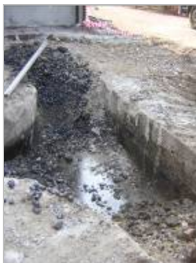
Bonifica e demolizione di serbatoi dismessi e di terreno contaminato da idrocarburi.
