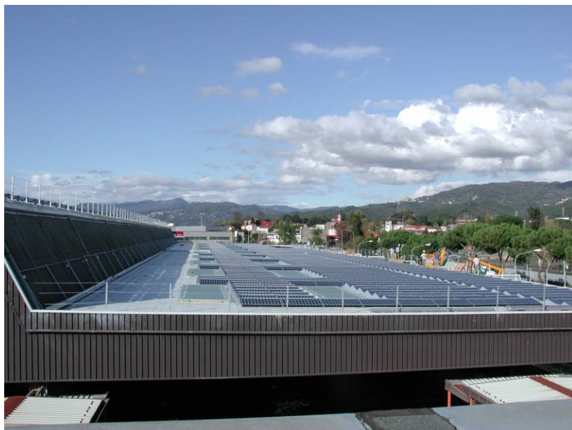
Figura 2 – Esempio di installazione idonea alla classificazione dell’impianto fotovoltaico nella categoria “su edifici” in caso assenza di una balastra perimetrale
